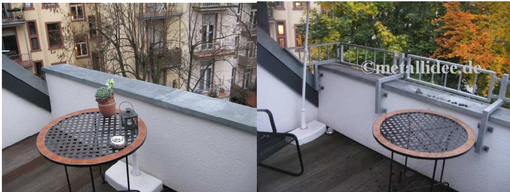
Montage eines 2-tlg. verz. Geländer Maße 3220x1200 aus Handlauf Rundrohr 33,7 mm mit senkrechten Stäben Vkt. 12 mm (Füllung) + Untergurt Flach 30x5. Dazu ein links ein 3ck Feld 200x1200 passend und rechts mit Halter an der Wand befestigen. Höhe 200mm. Befestigung über 3 Stck. Pfosten stirnseitig.
